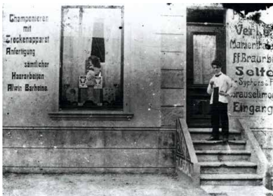
Alwin Barheine vor seinem Damensalon ca. 1910. Man beachte den Schriftzug „Damen-Frisiersalon“ auf dem seitlichen Mauerwerk des Treppenaufgangs
